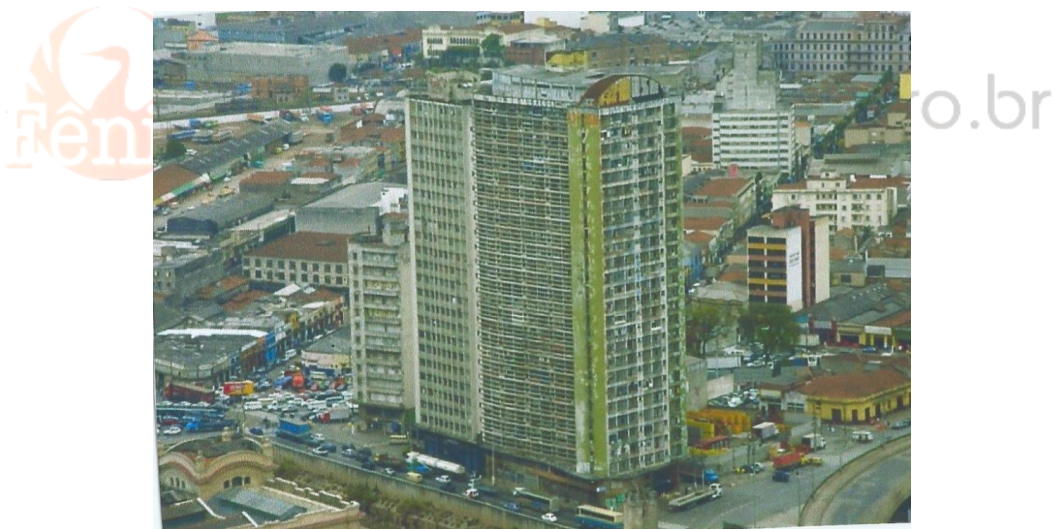
Figura: 6 Edifício São Vito e edifício Mercúrio às margens do rio Tamanduateí
