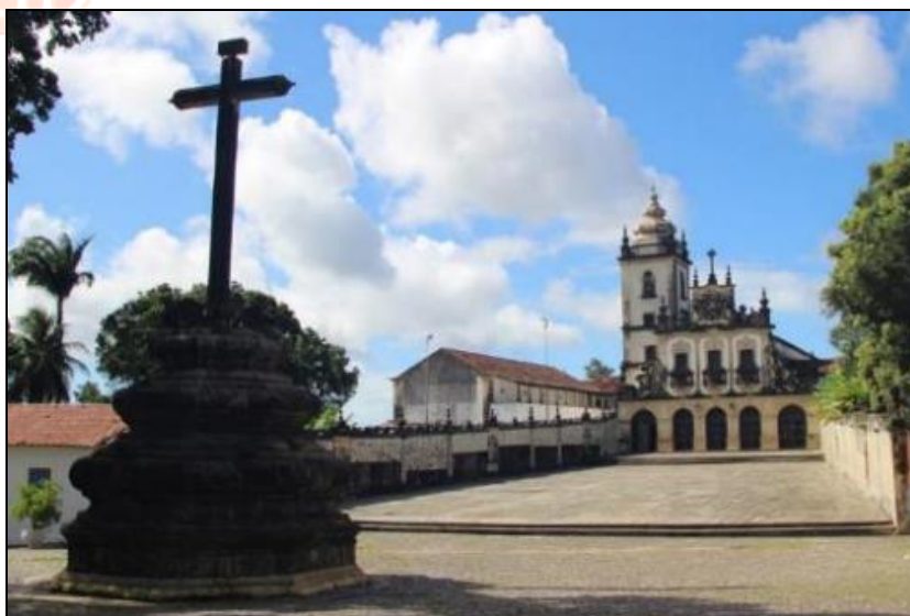
Figura 2. Cruzeiro, adro e fachada do Convento de Santo Antônio da Paraíba, finalizados em 1779
