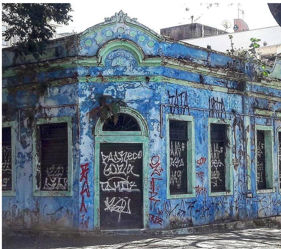
Figura 1 – edificação civil construída por Luiz Olivieri em estado de abandono. FONTE: arquivo pessoal do autor
