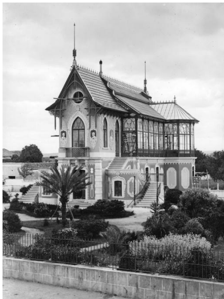
Figura 4 – Vista sudoeste do estúdio Carlos Relvas em 1876. Fonte: www.imagensrelvas.com 19
