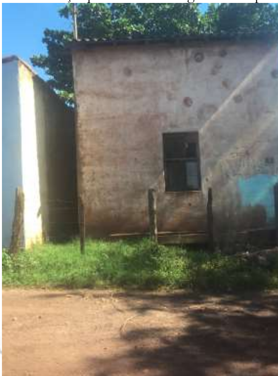
Figura 6. Antiga casa de força que fornecia energia elétrica para a Comista
